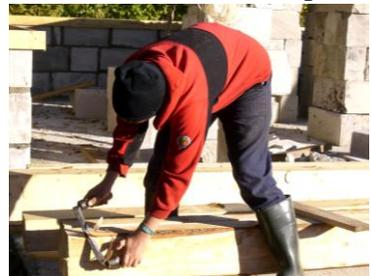
Hinter Johannes erkennt man den bereits gemauerten Sockel. Auch die Balken sind schon zugeschnitten, die Kopfbänder fast alle fertig und die Zapfenlöcher werden gerade gestemmt.
